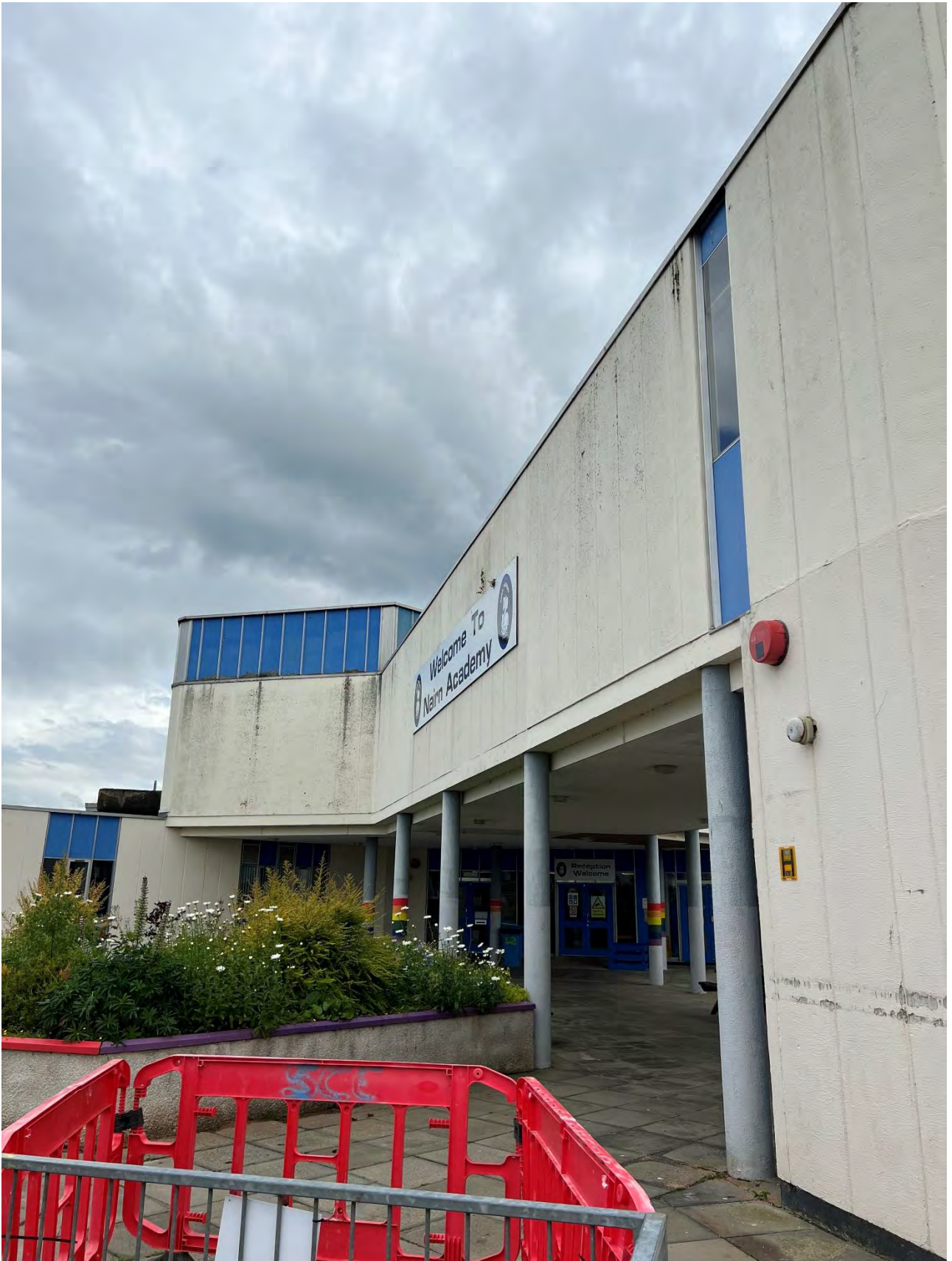
Photo N.14 External Siporex wall panels
